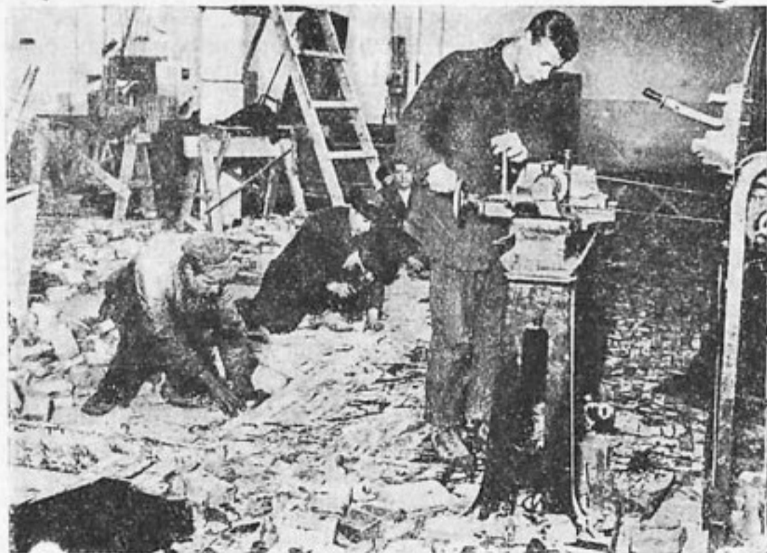
В последние дни перед окончанием строительных работ на Нижегородском заводе монтажники чувствовали строителей буквально у себя за спиной
