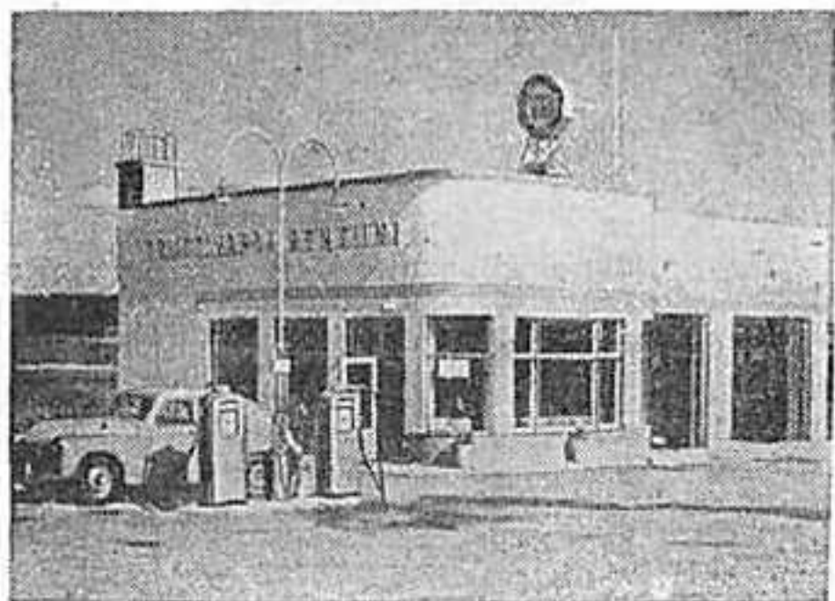
Дорожная станция обслуживания.
