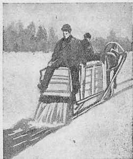
Рис. 8. Поливка полотна сплошной ледяной дороги
