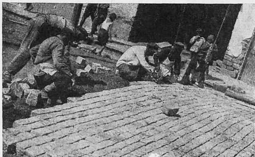
Брусчатка приходит на смену булыжнику. Строительство новых мостовых в Баку (Фото Союзфото)
