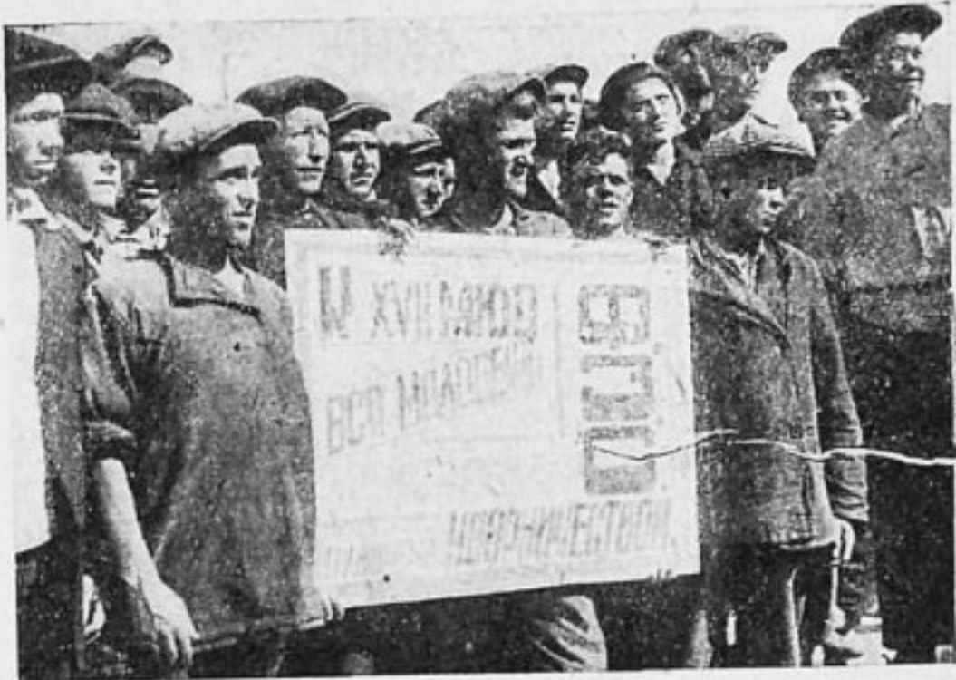
На стройке АМО. Ударная бригада молодых строителей
