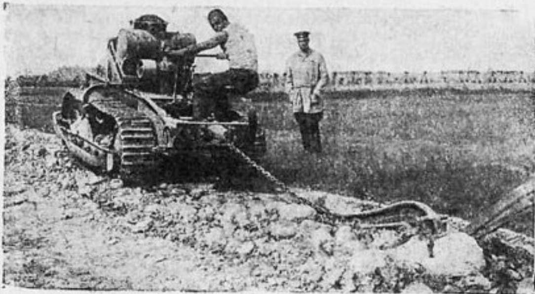
Работы с дорожным рутером (особым плугом) на каменистой почве
